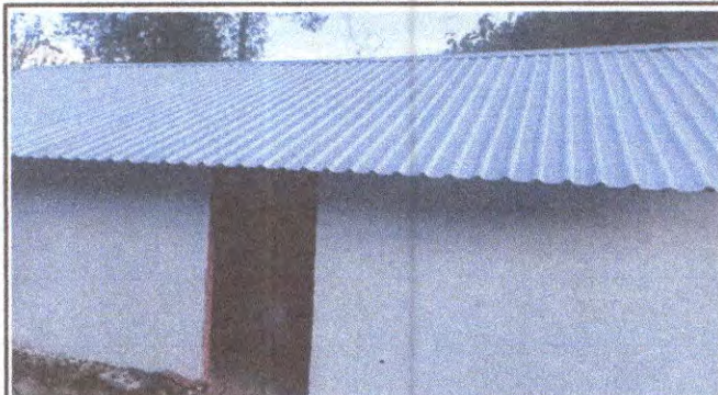
Foto 1: sustitución de lámina, por lamina troquelada aluzinc calibre 26 en modulo de cocina
