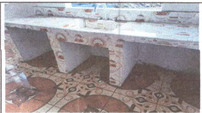
Foto 9: sustitución de lavatrastes en el area de cocina
