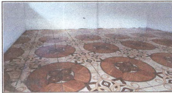
Foto 5: sustitución de piso de torta de concreto por piso cerámico en el interior del area de cocina.
