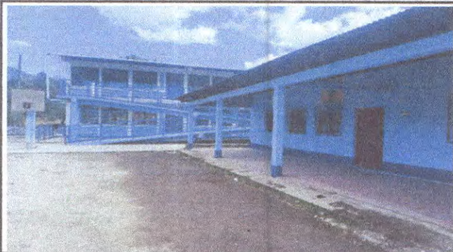
Foto 7: pintura en paredes exteriores en los módulos 2 y 3
