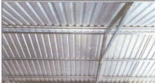
Foto 2: sustitución de soporte de madera por metal en el techo de la cocina escolar
