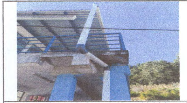
Foto 6: , sustitución de bajadas de agua pluvial en modulo 3 de la escuela
