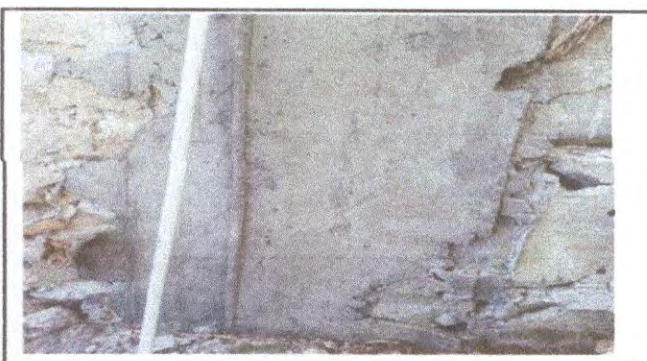
Foto 10: reparacion de columnas en muro de contención de la cocina
